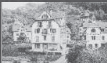
Die Bautätigkeit im Dorfzentrum – hier die «Neue Rigistrasse» aus dem Jahr 1906 – setzt dem Schiessstand neben dem Alt-Schulhaus ein Ende.
