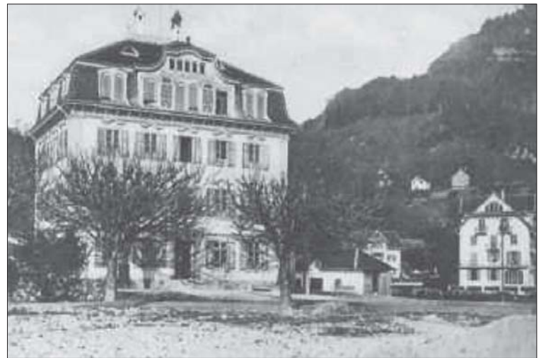
1907, Aufstockung und neobarocke Fassade: Das Schulhaus war zu klein geworden. Um mehr Platz zu schaffen wurde es mit einem Mansardenstock und einem Walmdach aufgestockt. Diese Bauphase bildet die Grundlage für die farbliche Neugestaltung 2018 (Bild von 1908).
