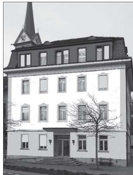
2018, Erneuerung Mansardenstock, Walmdach und Aussensanierung: Stilelemente und Farbgestaltung der neobarocken Bauphase 1907 bis 1947 bilden die Grundlage für die Gestaltung des Alten Schulhauses (Farbkonzept 2018).
