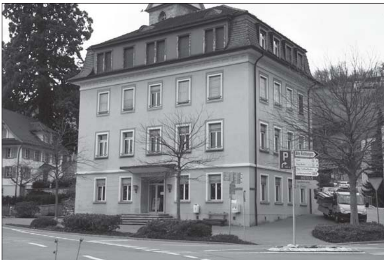
1947, Aussenrenovation und Purifizierung: Die neobarocken Elemente wurden entfernt. 1953 wurden die Jalousieläden durch Raffstoren ersetzt (Bild von 2017).
