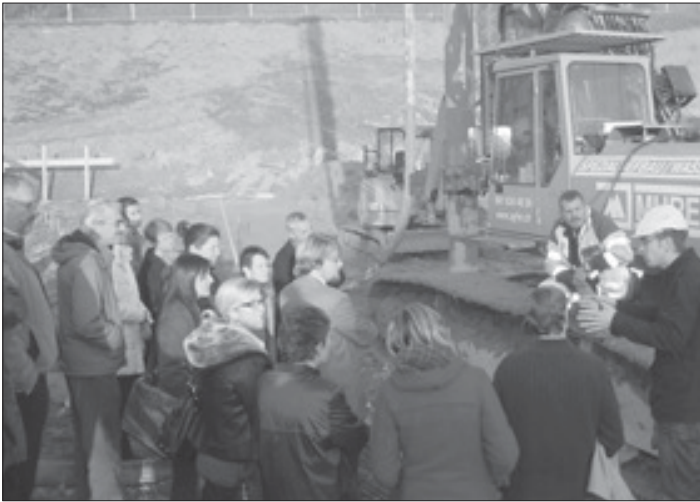
Bauleiter Urban Jung (ganz rechts) erläutert die Pfählungen auf der Baustelle im Dörfli.
