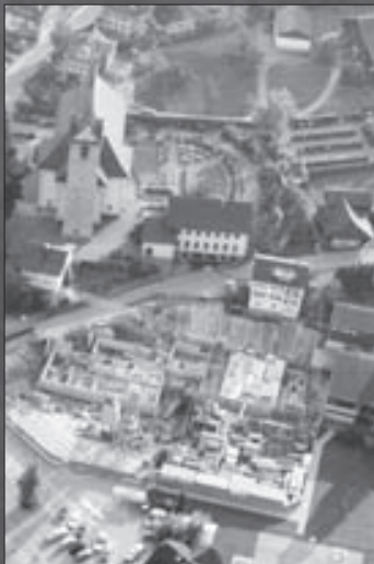
«Die Schule soll im Zentrum bleiben!» Hier die Baustelle zwischen Dorf- und Kirchmattschulhaus am 18. Juni 1980.
