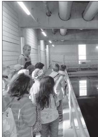
Rundgang bei den Vorklärbecken.
