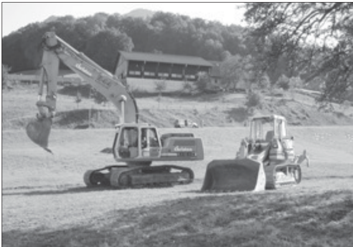
...und am Mittwoch fahren die grossen Baumaschinen auf.
