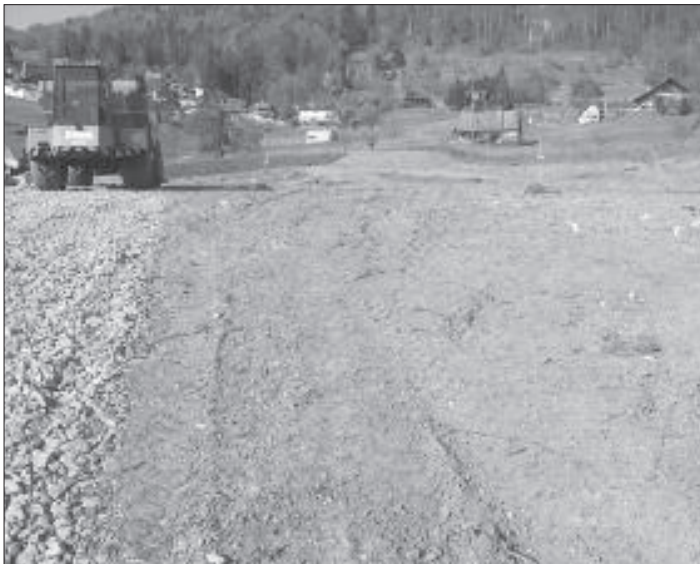
Auf einer grossen Fläche bei der Blauweid wurde die Humusschicht entfernt.
