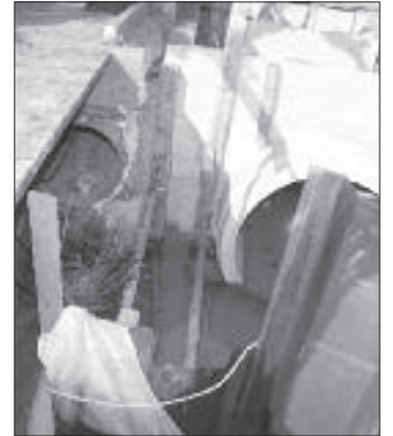
Neben der alten Leitung wurden zusätzlich neue Röhren eingebaut.
